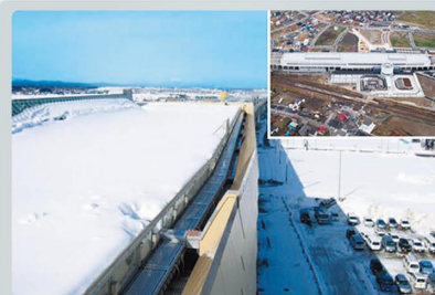
屋根融雪ヒーター制御システム（新幹線駅・屋根上屋） （（公財）鉄道総合技術研究所様と共同開発）
